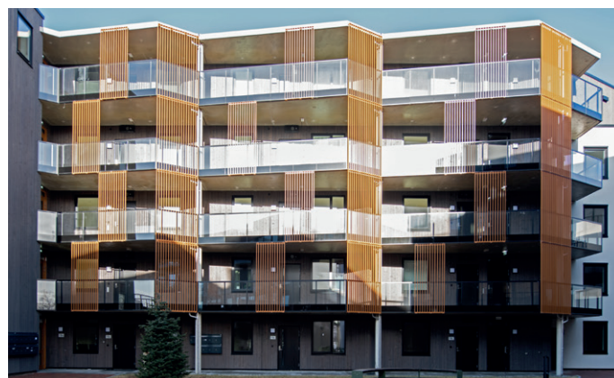
Liv i fasaden på Bygg C.
